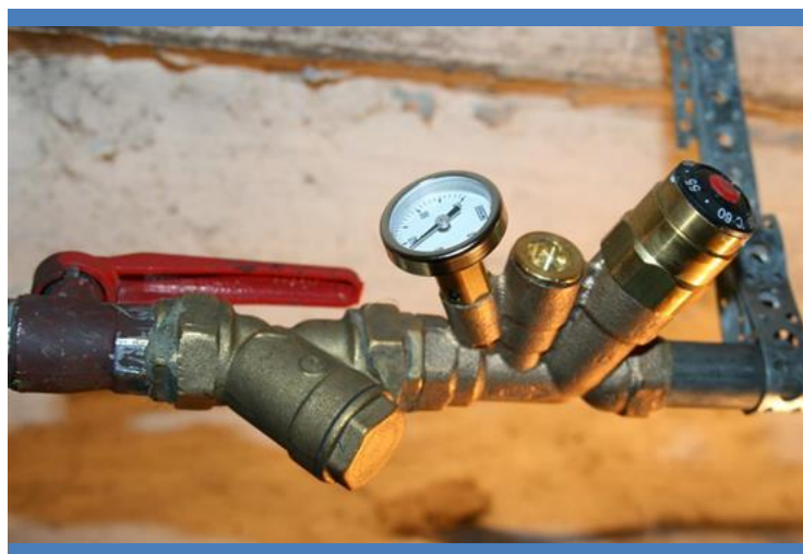
4.3.3.2. pav. Karšto vandens sistemų balansavimas.
