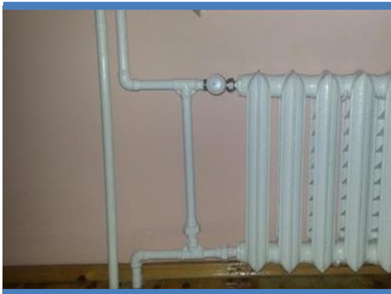
4.3.4.8. pav. Rekonstruota vienvamzdė šildymo sistema su termostatinio ventiliu ir jungiamuoju vamzdžiu su diafragma.
