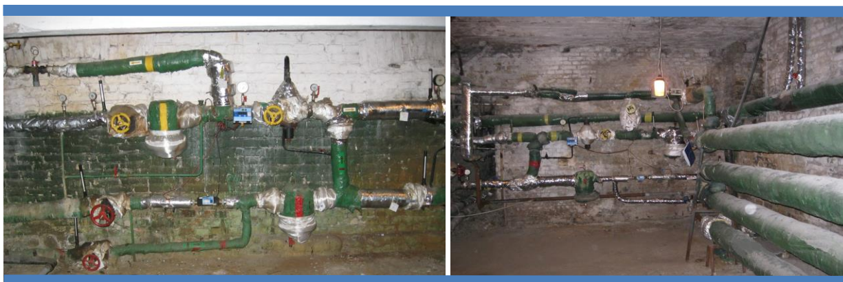
4.3.1.2. pav. Priklausomo tipo šilumos punktas su elevatoriumi.
