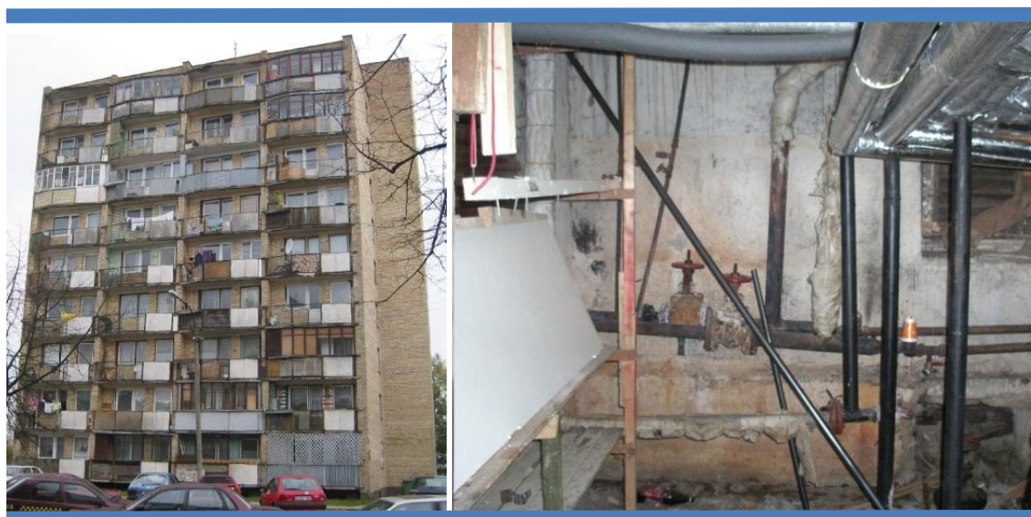
3.1.2.15. Pav. Senas neprižiūrimas daugiabutis ir jo vidaus šildymo ir karšto vandens sistemos dalies būklė
