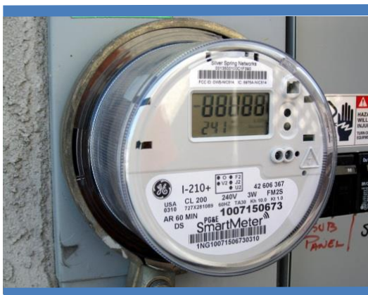
4.3.6.2. pav. Magneto poveikiui atsparus skaitiklis.
