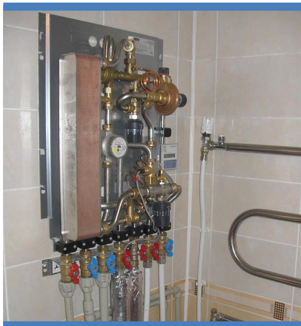
4.3.1.7. pav. Individualus nepriklausomo tipo šilumos punktas kiekvienam butui.
