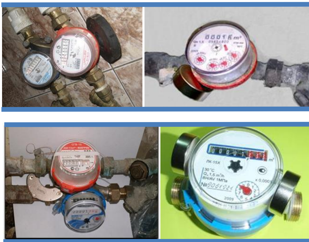
4.3.6.1. pav. Magnetai ant vandens skaitiklių.
