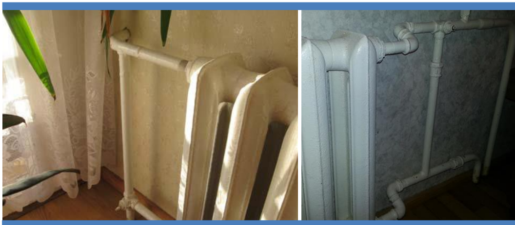
4.3.4.7. pav. Vienvamzdė šildymo sistema su jungiamuoju vamzdžiu ir trieigiu pamaišymo ventiliu.
