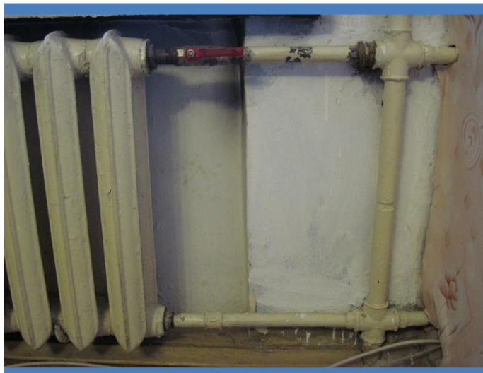
4.3.4.6. pav. Vienvamzdės šildymo sistemos su neatitrauktu jungiamuoju vamzdžiu be trieigio pamaišymo ventilio pavyzdys.
