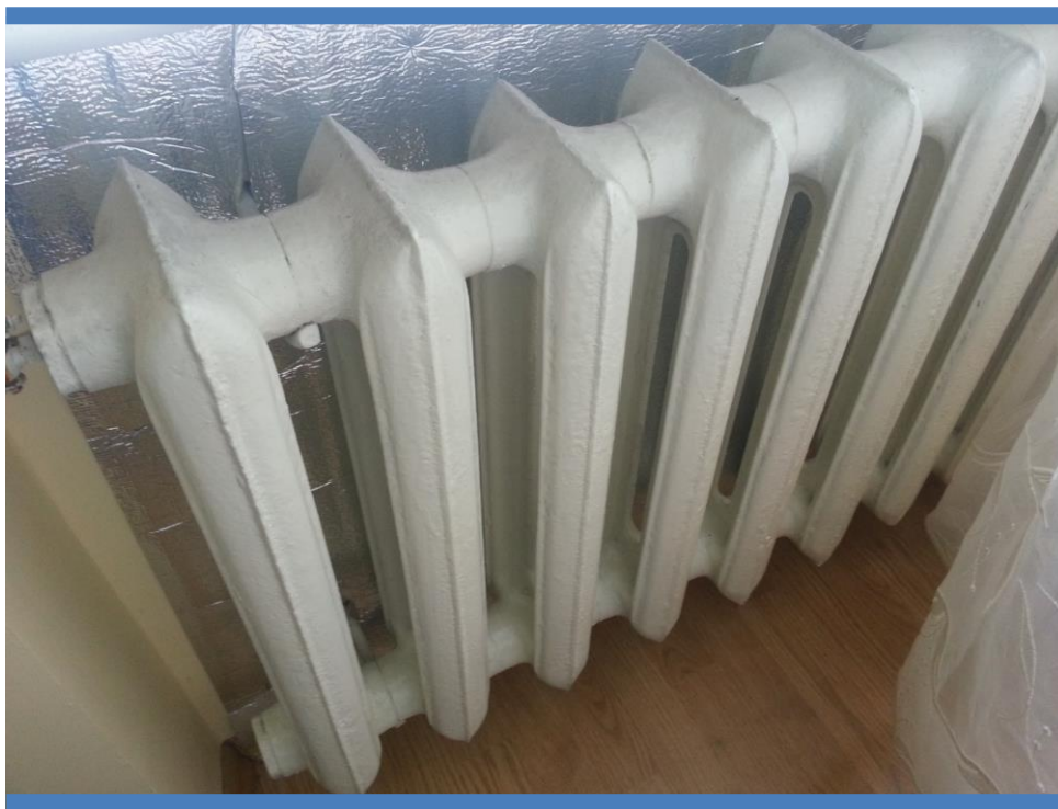
4.3.10.2. pav. Ekranas už šildymo prietaiso.
